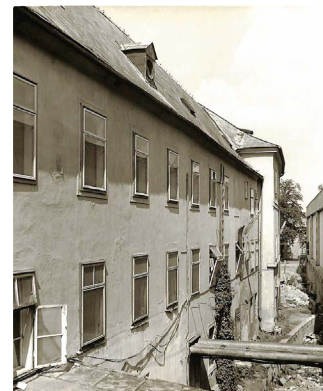
Auf diesem Bild sieht man noch einen Teil der Befestigungsmauer des Mühlbachs, der früher an dieser Stelle der Grünmühle vorbeifloss und ein Wasserrad in Gang hielt.
